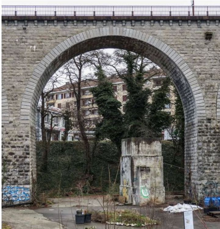
Une arche du viaduc du Galicien, avec un regard des égouts empruntant le lit du ruisseau du même nom. Photo Avenir Malley
